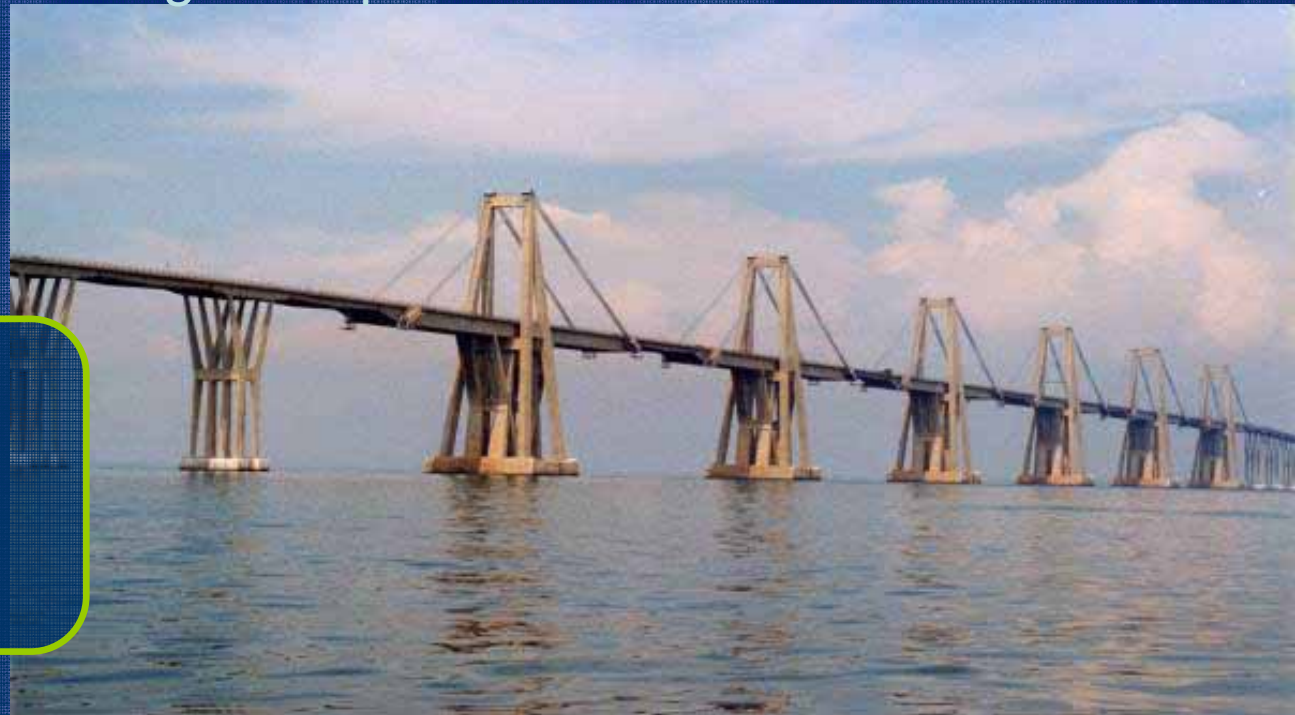
Most Maracaibo, Morandi, 1962. Betonske grede i piloni
