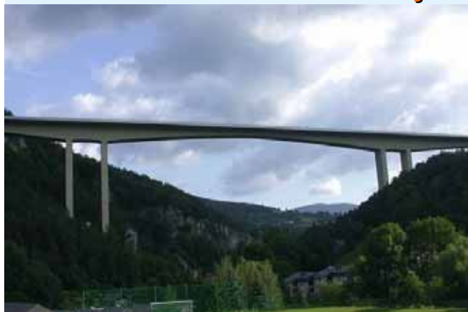
Most Schottwien, Austrija 1991. god, svijetli L stupova 20,5 m
