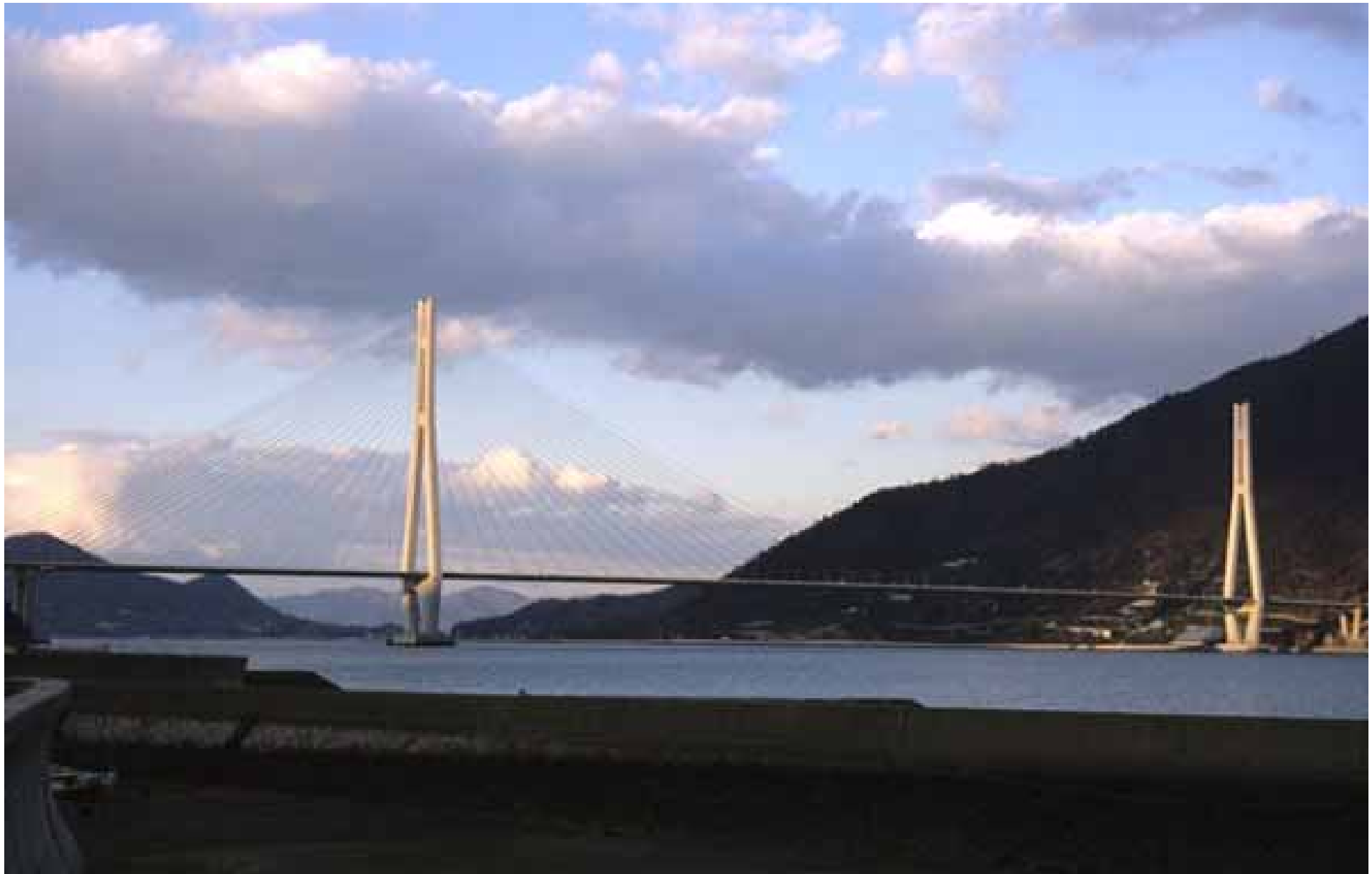
Tatara, Japan, 1999. g., najveći čelični ovješeni most, 270 m + 890 m + 320 m slobodni profil 26,0 m; širina grede b=30,6 m; visina pilona H=220 m
