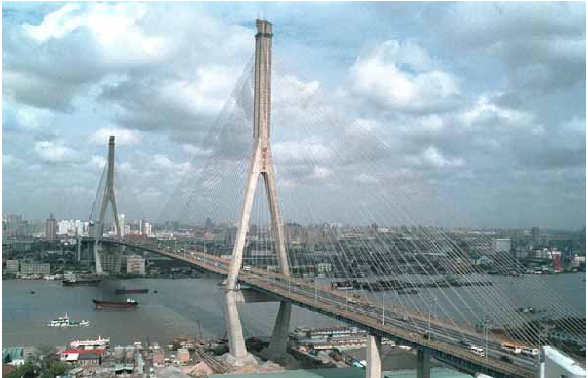
Yangpu, Kina, 1993. g., najveća spregnuta greda, 99 + 144 + 602 + 144 + 99 m širina grede b=30,35 m; visina pilona H=223 m
