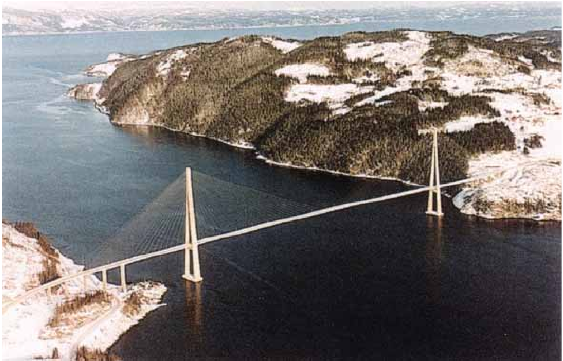
Skarnsundet, Norveška, 1991. g., najveći betonski ovješeni, L=530 m širina grede b=13,0 m; visina grede h=2,15 m, visina pilona H=152 m
