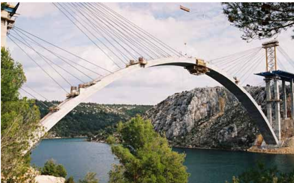
Izvedba krajnjeg spojnog segmenta
