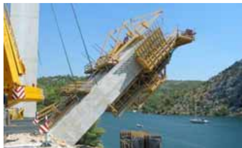
Izvedba pete i početnog segmenta
