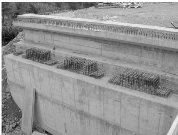
primjer betonskog masivnog upornjaka
