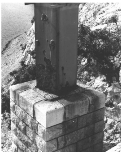
oštećenja starog Masleničkog mosta zbog korozije
