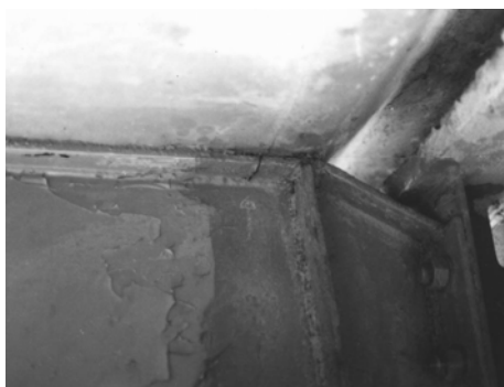
oštećenja starog Masleničkog mosta zbog korozije
