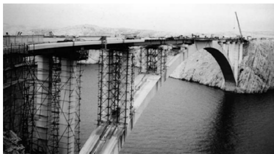
sanacija luka i stupova Paškog mosta koji su oštećeni uslijed korozije armature
