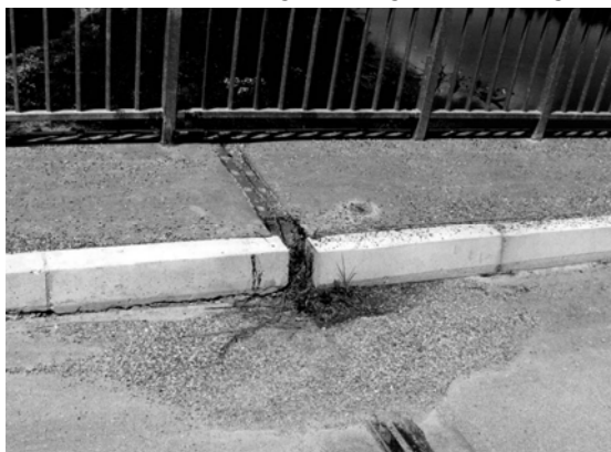
prijelazna naprava koja zahtijeva čišćenje
