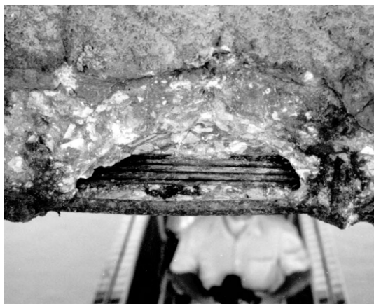
oštećenja na Paškom mostu zbog propadanja armiranog betona
