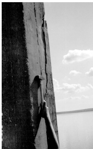
oštećenja na Paškom mostu zbog propadanja armiranog betona
