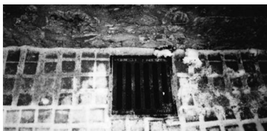
osobito su važni radovi na čišćenju slivnika kako voda ne bi oštećivala dijelove konstrukcije
