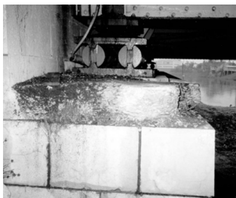
dotrajali ležajevi koji zahtijevaju zamjenu
