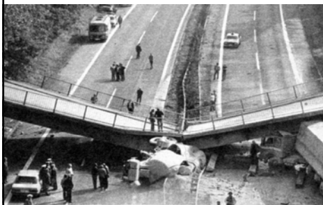
udar vozila u stup nadvožnjaka uslijed kojeg se most srušio i...
