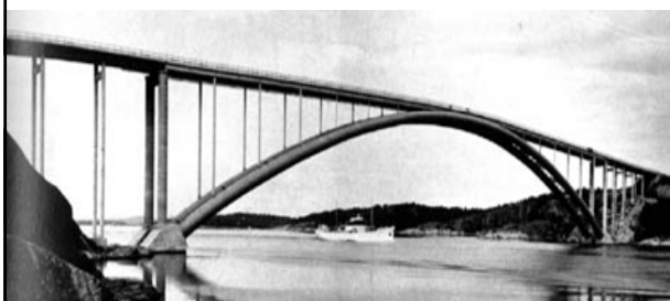
most u Švedskoj koji se srušio uslijed udara broda u luk i...
