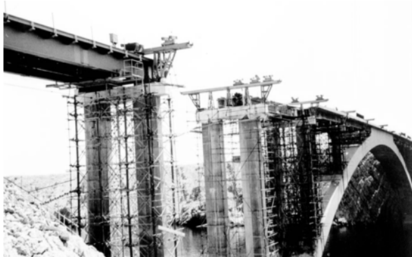
planirano rušenje Paškog mosta zbog zamjene nadlučnog sklopa
