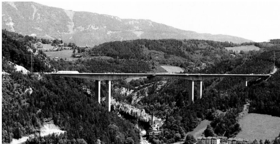
most Schottwien u Austriji, sagrađen 1989.g., raspon 250m
