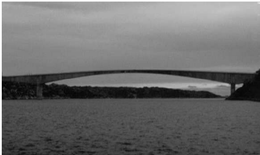
most Stolmasundet u Norveškoj, sagrađen 1998.g., raspon 301m
