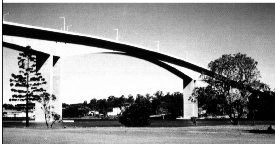
most Gateway u Australiji, sagrađen 1986.g., raspon 260m
