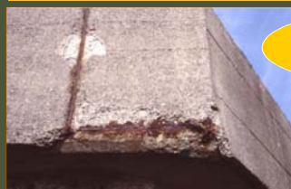
Lokalna (točkasta) korozija
