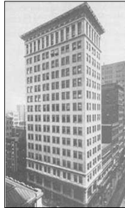
Ingalls zgrada – prvi betonski neboder
