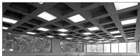
AB roštilj u konstrukciji poslovne zgrade
