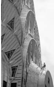
Dijelovi Chrysler zgrade izrađeni iz nehrđajućeg čelika
