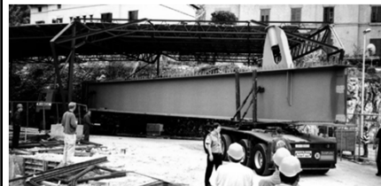
transport gotovih nosača Dubrovačkog mosta specijalnim vozilom
