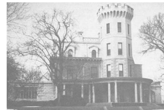
Prva građevina od armiranog betona 1871.-1875. Port Chester, NY
