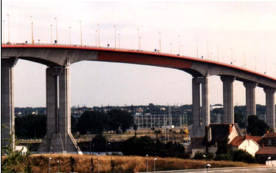
Most Chevire , raspon čelične grede= 162 m
