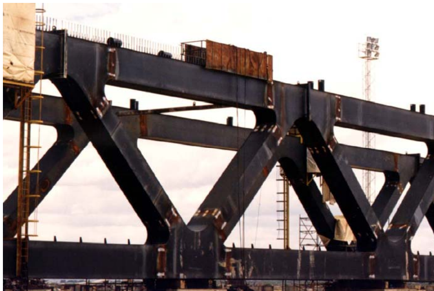
Most Öresund – rešetkasti rasponski sklop u fazi izvedbe
